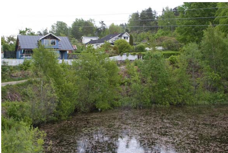
Bilde 7: Oversiktsbilde av den nordre del av Kvistemyrdammen. Enkelte mindre trær står langs kanten av dammen.
